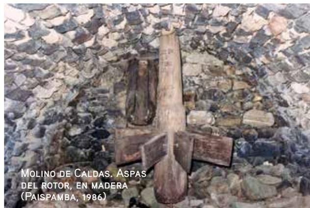
MOLINO DE CALDAS. ASPAS DEL ROTOR, EN MADERA (PAISPAMBA, 1986)
