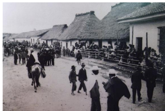
Lámina 7. Casas de Bahareque. Carrera 6 frente al Hospital San José (Archivo Ledezma)
